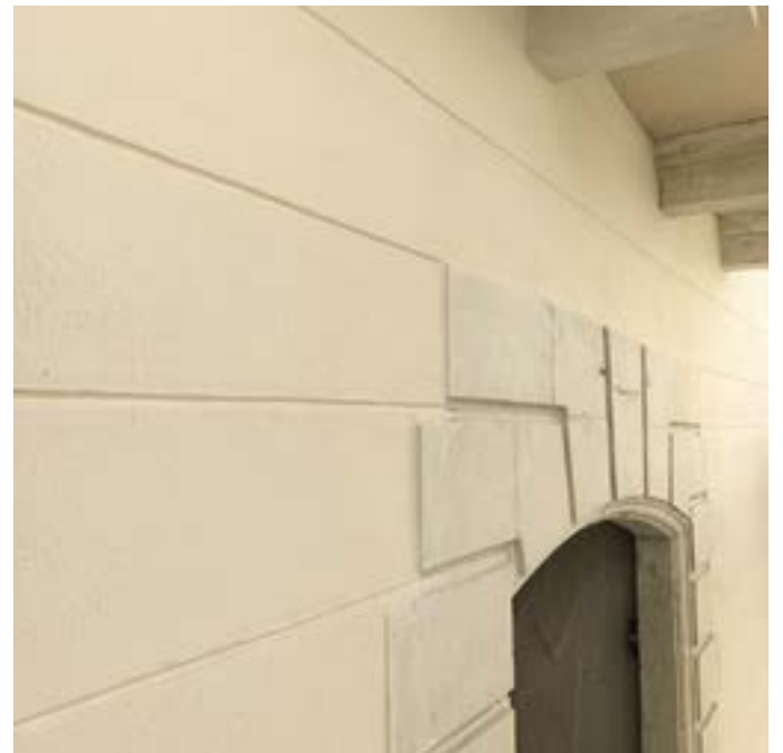
Fasce d'intonaco e imbotti in pietra
