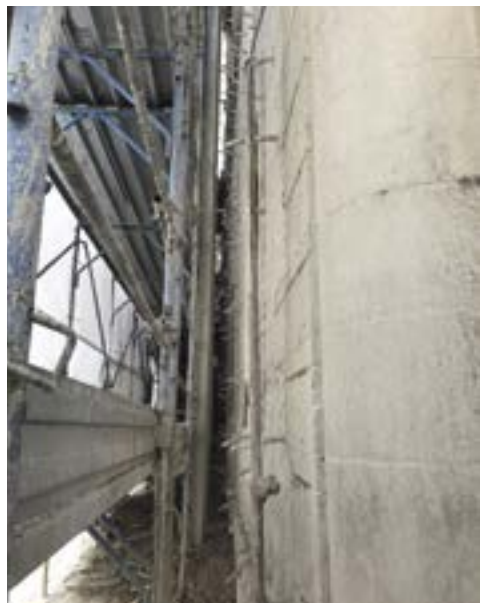
Interventi strutturali sulla muratura con iniezioni
