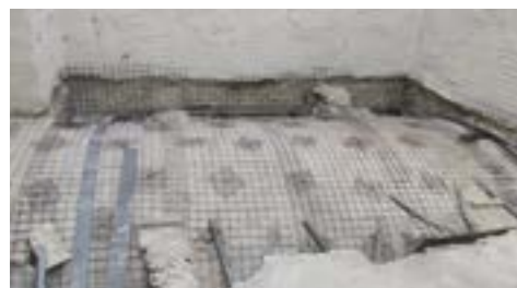
Sostituzione dei solai intermedi con armatura di ripartizione e cordolatura perimetrale con angolare metallico fissato in parete
