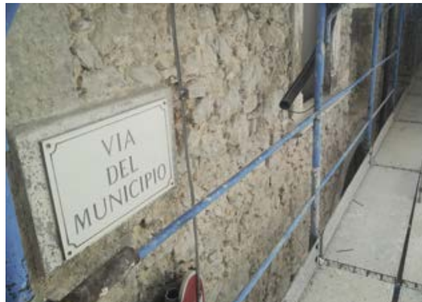
Messa a nudo della muratura portante
