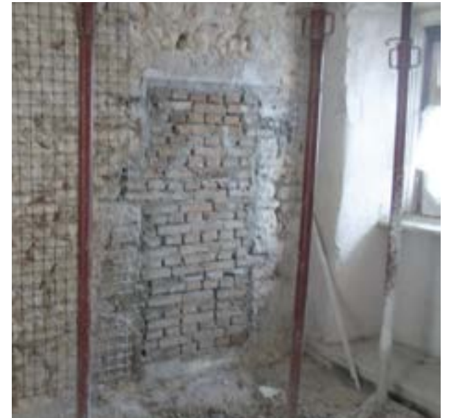
Chiusura delle nicchie con mattoni pieni in laterizio
