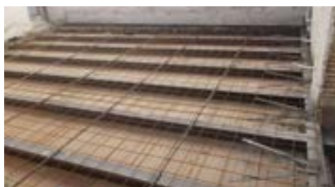
Sostituzione dei solai intermedi con armatura di ripartizione e cordolatura perimetrale con angolare metallico fissato in parete
